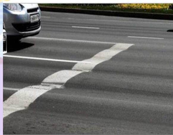
1.2-rasm. Yo'l qoplamasi va yo'l poyidagi deformatsiyalarning o'zaro bog'liqligi.
